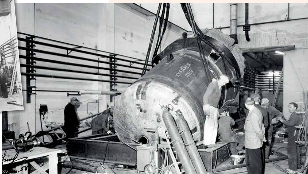
Reaktortanken som heises på plass i Halden. På reaktortanken kan vi se «Kværner» inngravert. Foto: IFE
