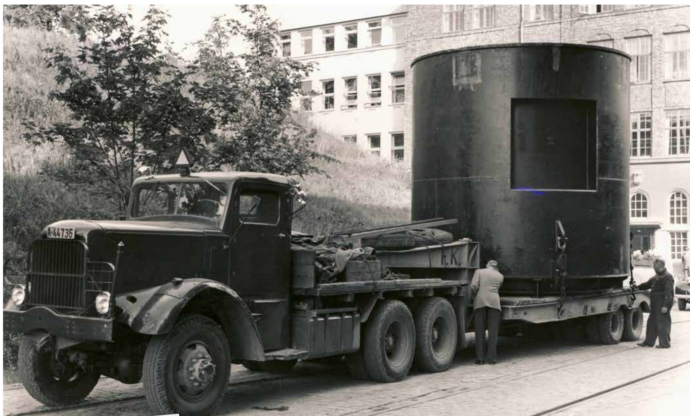
Når man skulle bygge reaktor i Norge var det fokus på synergier i industrien. Reaktortanken til Haldenreaktoren ble bygget av Kværner Brug AS. Foto: IFE
